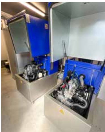
To Toyota Hiace-motorer driver generatorene som sørger for produksjon av 30 kilowatt i timen.
